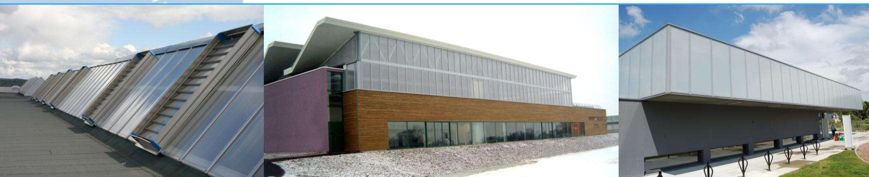
Le bardage VITR'AZUR polycarbonate confère une grande luminosité de façade aux bâtiments. Sa conception sur-mesure, sa souplesse de mise en oeuvre est la solution adaptée pour les salles de sport, usines et centres commerciaux.
